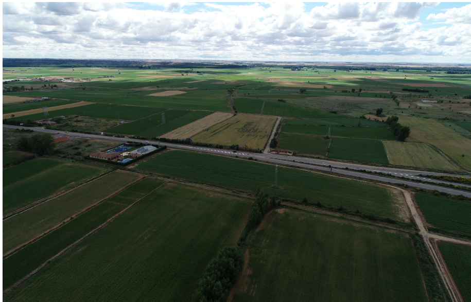
Fotografía 4: Zona de ubicación de glorieta sobre N-630
