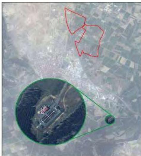
Figura: EDAR Benavente.
