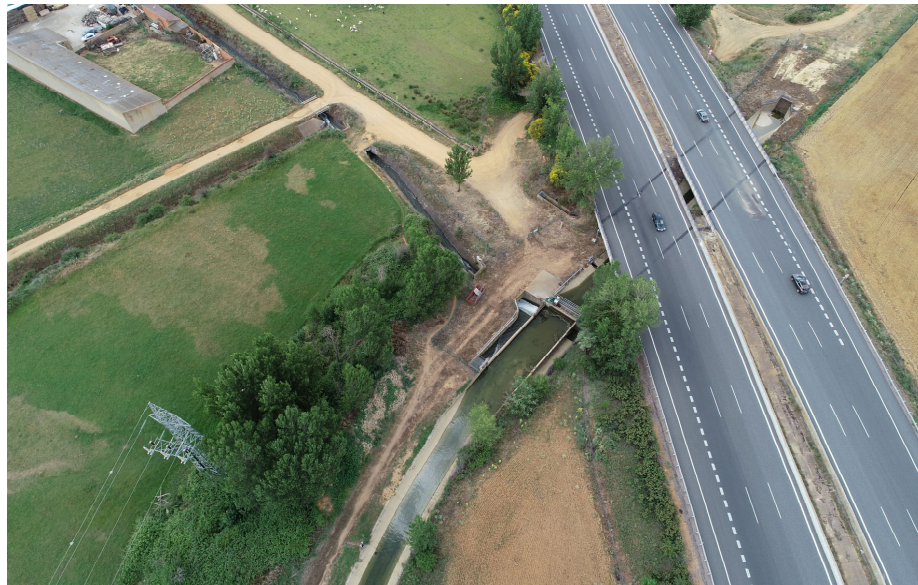
Fotografía 1: Paso del canal del Esla bajo la A-6 y desagüe D-53
